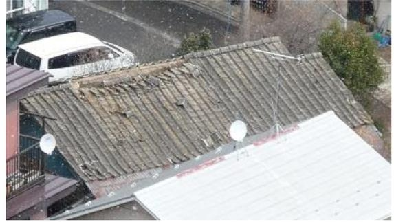
写真-1 東日本大震災時の屋根瓦の被害例
