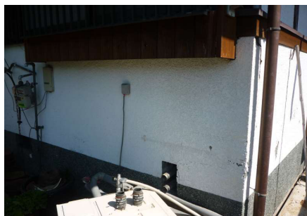
写真-8 浴室回り高基礎(ブロック)
