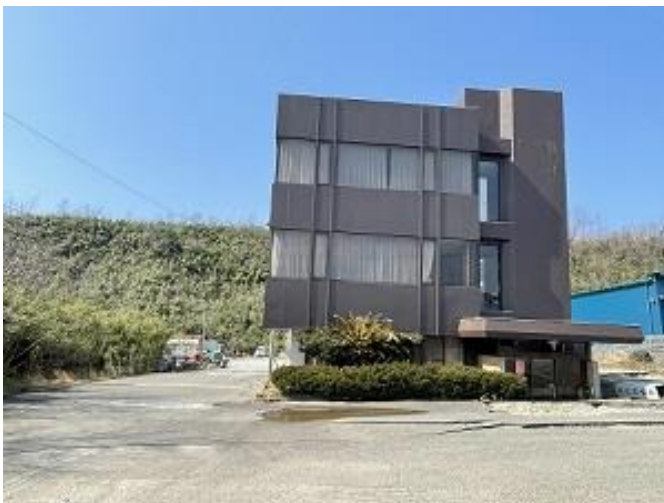
画像-1 液状化により埋没した建物
