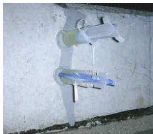
エポキシ樹脂注入
