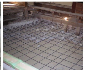
底盤幅拡張(べた基礎化)
