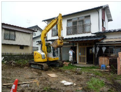
写真-1 重機加振状況
