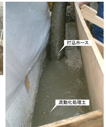
写真4 流動化処理土
