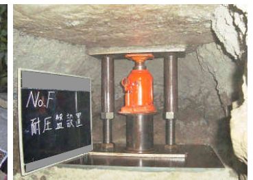
写真2 仮受・ジャッキアップ
